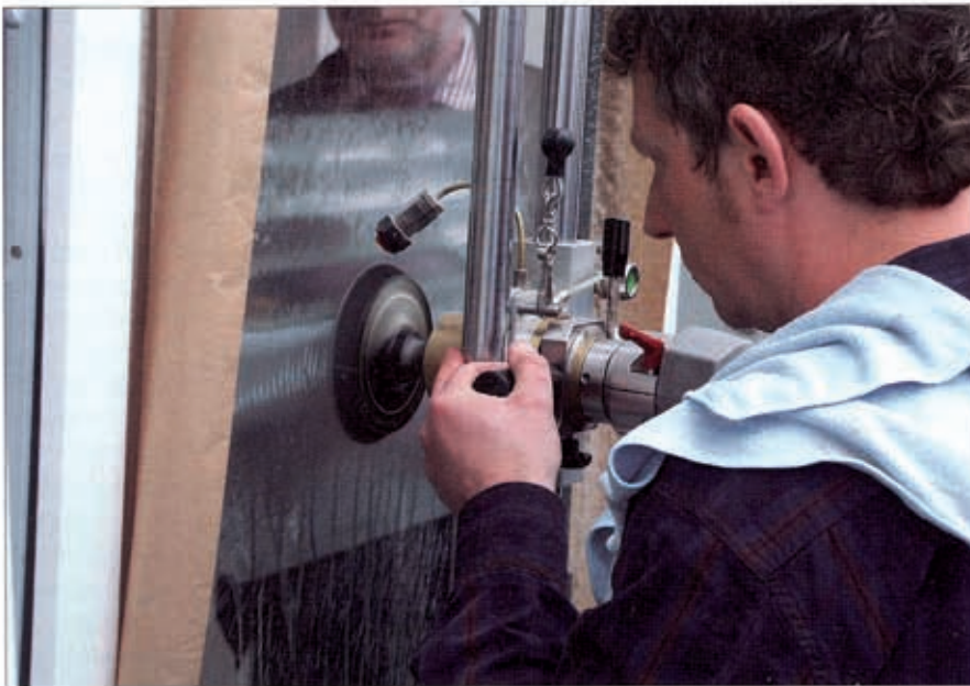
Die Flächenbearbeitung erfolgte mit zunehmend feiner werdenden Schleifmitteln.
